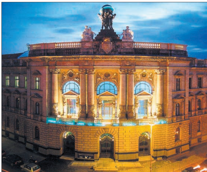
Unser Tagungsort: Blick auf den abgerundeten Eckbau des Museums bei Dunkelheit. Das Haus wird nachts von innen blau erleuchtet. Foto: Herbert Schlemmer
